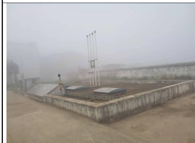
加油站油罐区
