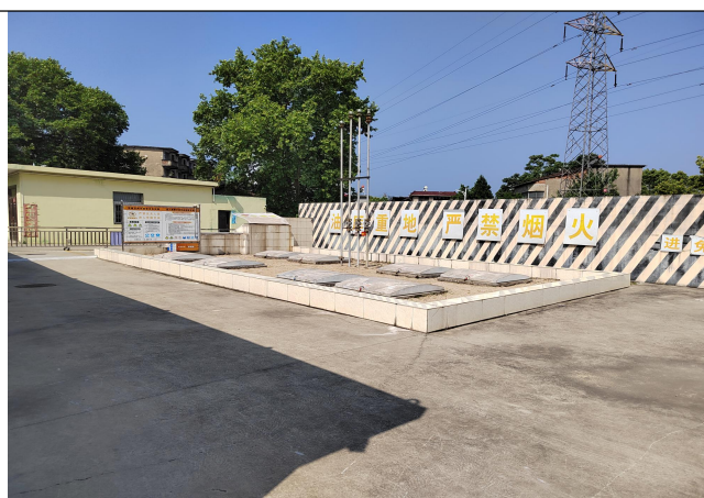
加油站油罐区
