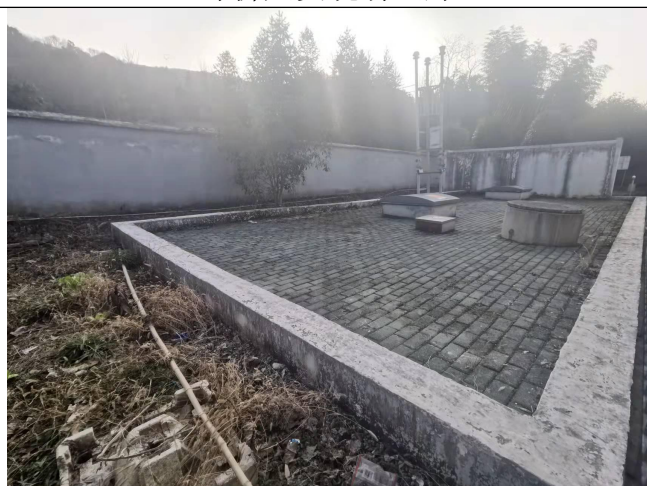
加油站油罐区
