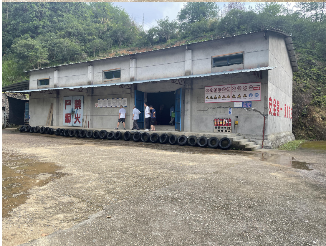
评价人员现场勘察照片
